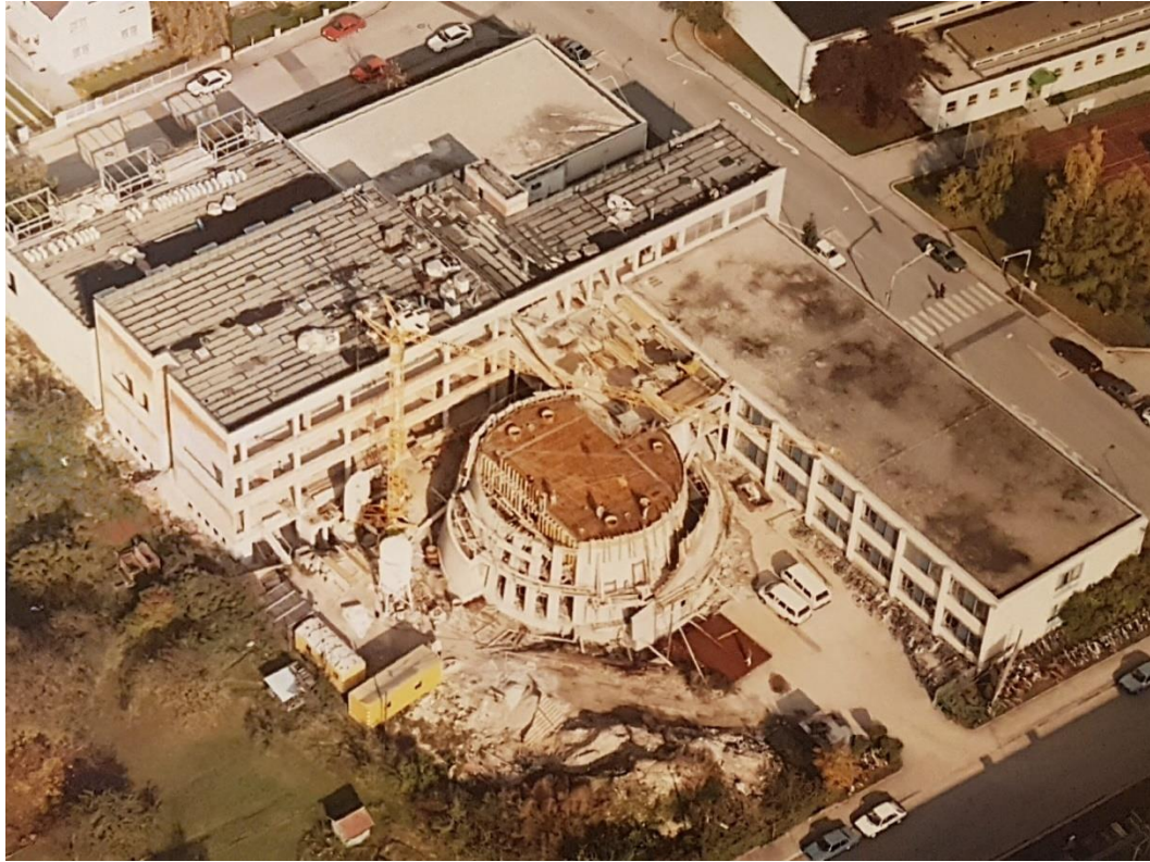
Abbildung 5: Bauarbeiten BRG Wels Wallererstraße (Quelle: www.brqwels.at )
